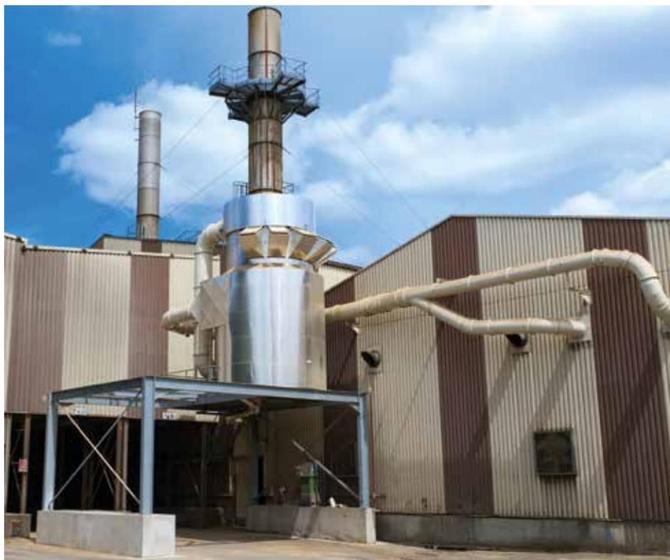
Le Cyclofiltre a été spécialement conçu et développé pour filtrer l'air nécessaire à l'extraction de poussières et copeaux situés au cœur des process industriels.
