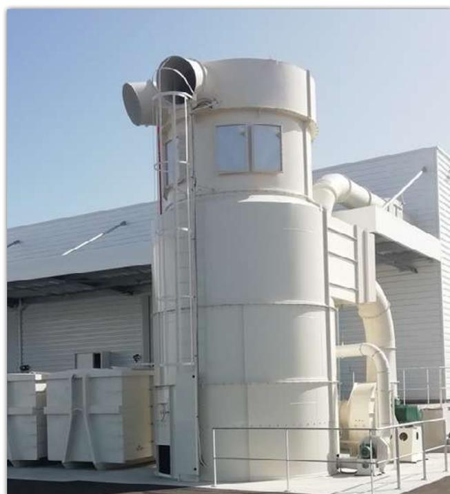
*Cyclofiltre 4X7 avec débit d'air de 31 000 m<sup>3</sup> / h pour aspirer les poussières de bois sur quatre centres d'usinage.*
