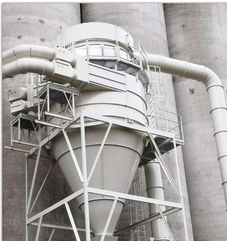
*Cyclofiltre 4Y9 avec un débit d'air de 86 000 m<sup>3</sup> / h.*
